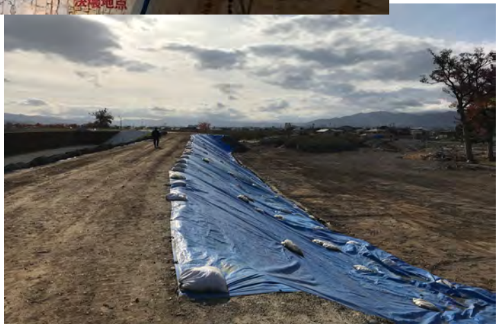
鉄柵にて応急修復された決壊現場
