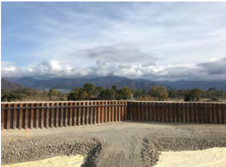
鉄柵にて応急修復された決壊現場
